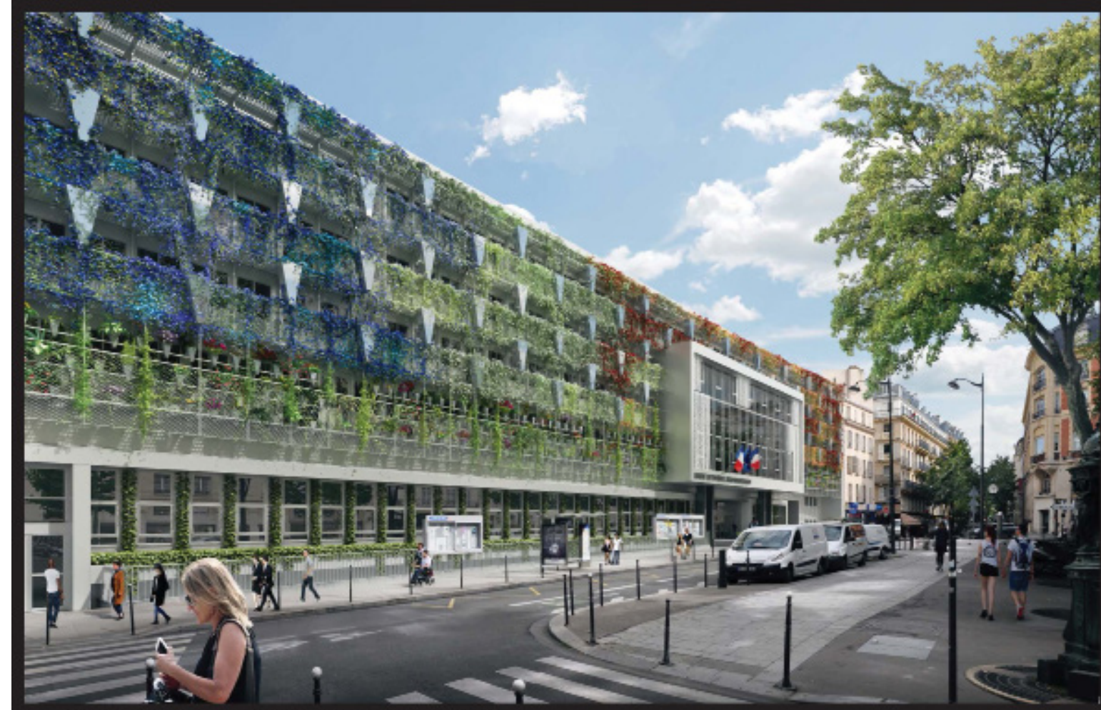
Façade végétalisée de la Mairie du 17 ème
